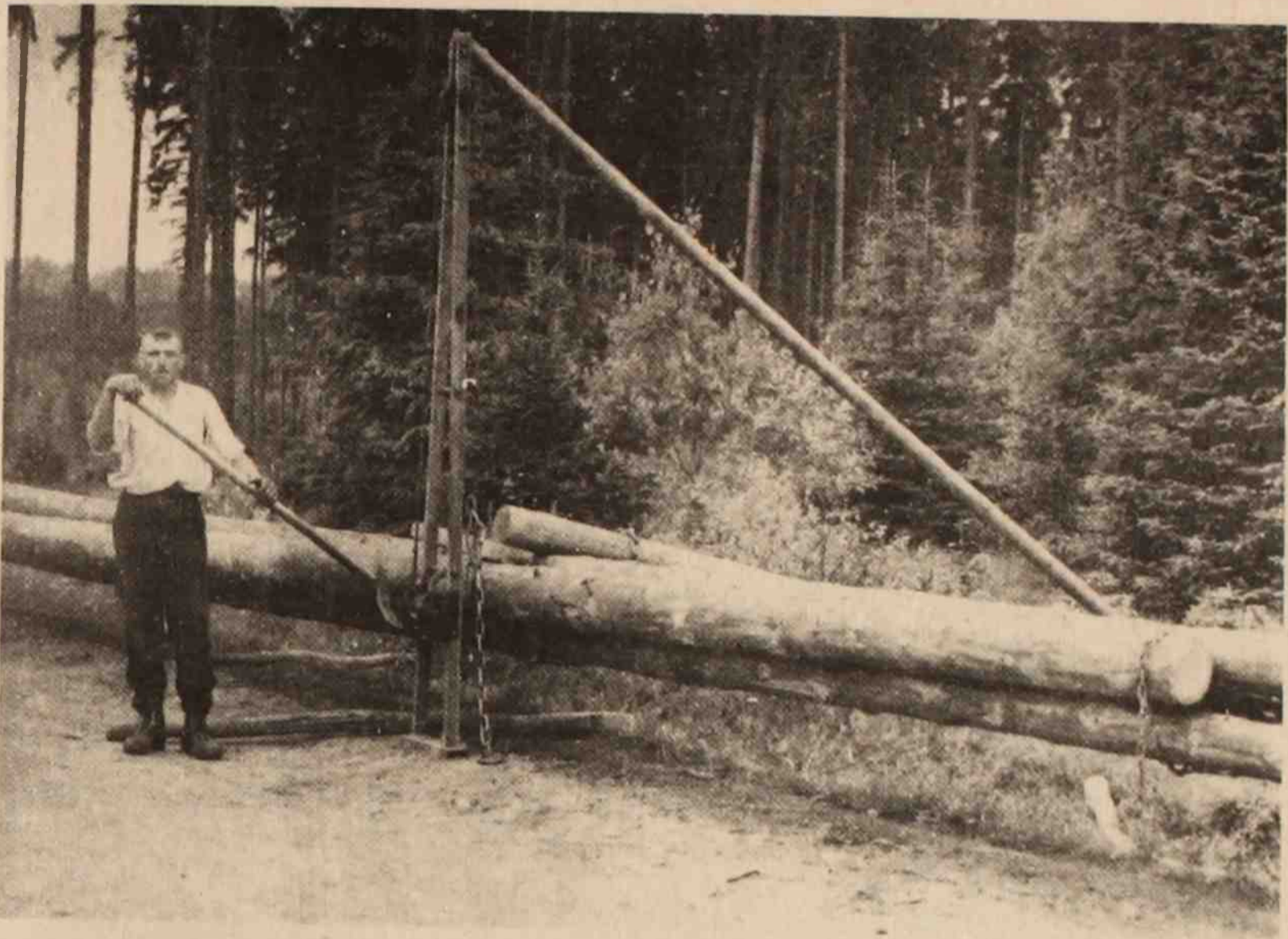
Obr.39,40) Nakládání a doprava kulatiny vozem systém Kolovrat na Přímdecku před koncem druhé světové války
