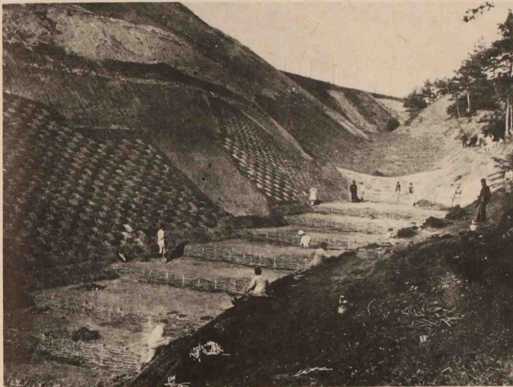
Obr.59 Počátky prací hrazení bystřin v Čechách z přelomu 19.a 20.století. Zpevnění rakovnických strží výplety prahů ve dně a zpevnění svahů výsadbou v garnýžích
