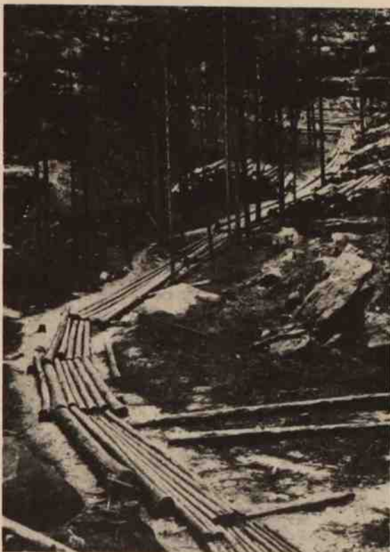
Obr.36) Skluz se složištěm dříví. Záběr z Českosaského Švýcarska z r.1921.
